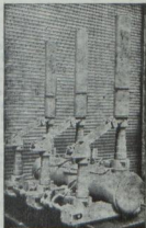
33kV, 1600 Amp, 1000M.V.A. Indoor Air-blast Circuit-breaker.
