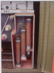
Fig. 3: SF6 RMU bushing arrangement.
